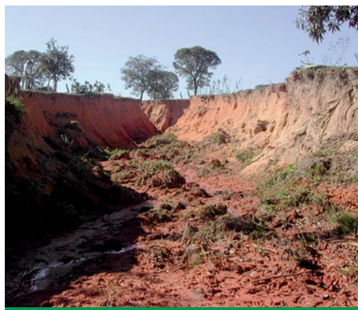
Figura 5. Erosão em boçoroca (observa-se a presença de água corrente no fundo da erosão)
