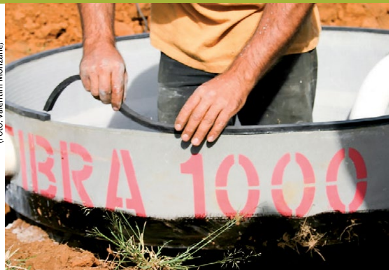
Figura 10. Vedação da boca de um módulo de fermentação, com o uso de guarnição esponjosa
