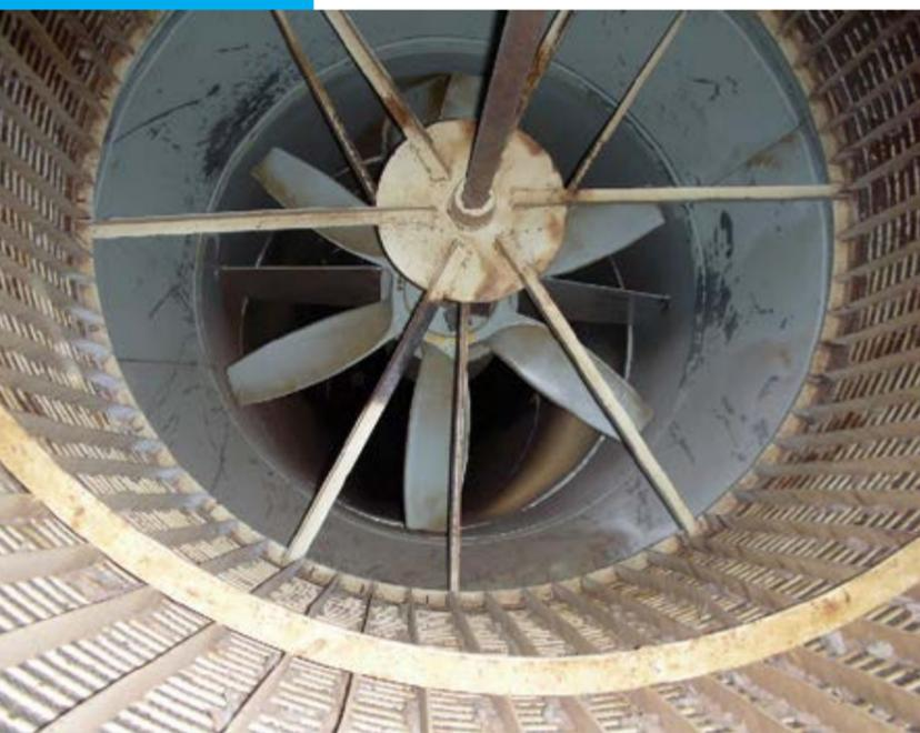
**Figura 8.16.** Ventilador axial simples. (Foto: Cotimes do Brasil, 2011).
