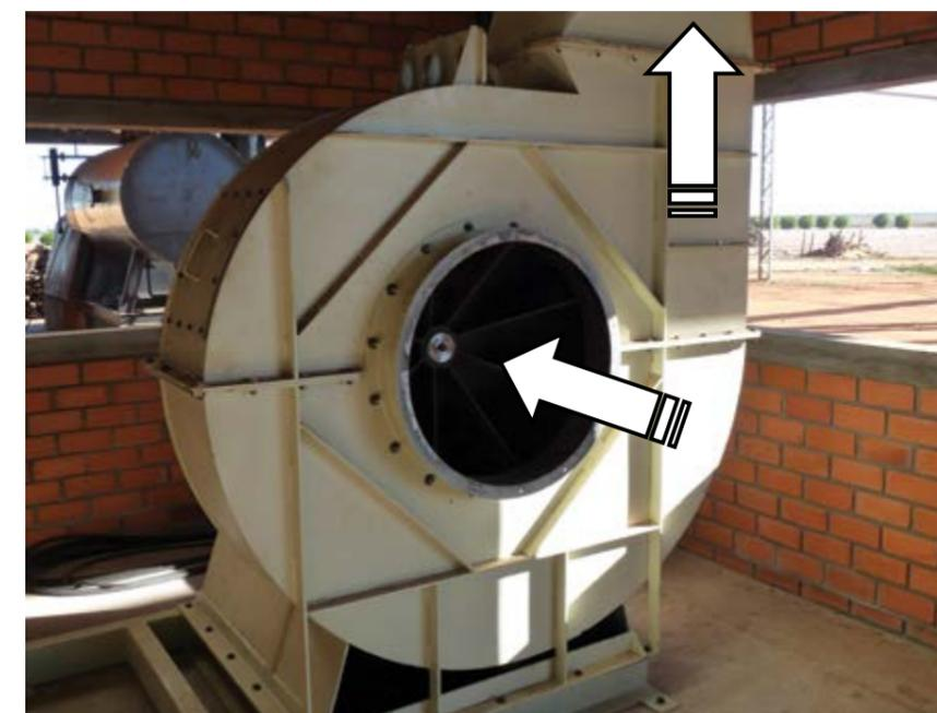
**Figura 8.11.** Ventilador centrífugo. (Foto: Cotimes do Brasil, 2011).
