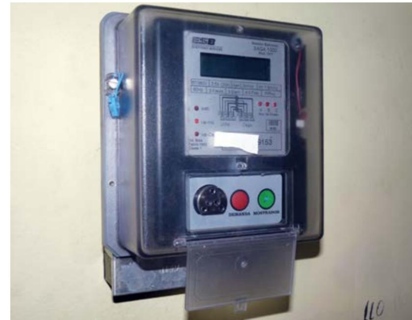
Figura 9.3. Medidor eletrônico (kWh, kWhr, kW, fp). (Foto: Cotimes do Brasil, 2011).
