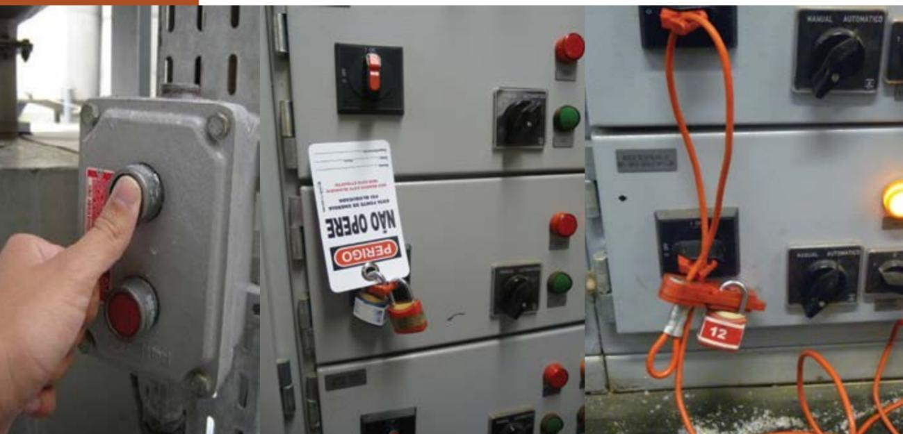
**Figura 12.2.** Proteção por bloqueio, aviso e teste.
