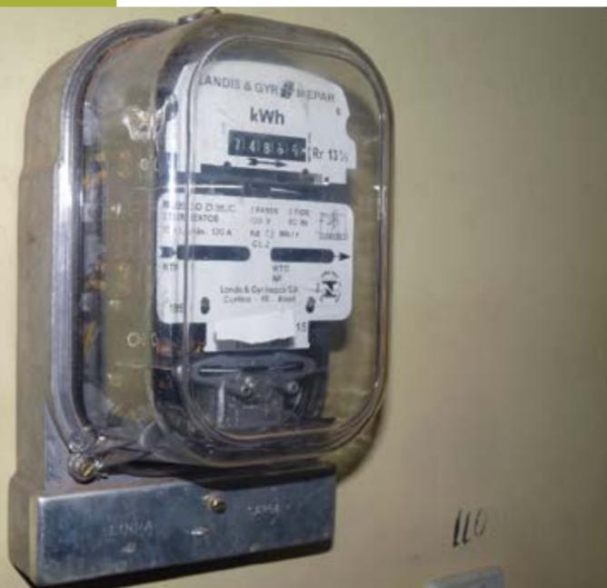
Figura 9.1. Medidor analógico kWh. (Foto: Cotimes do Brasil, 2011).
