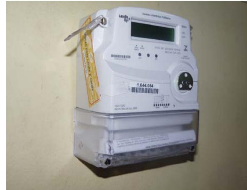
Figura 9.2. Medidor eletrônico (kWh, kWhr). (Foto: Cotimes do Brasil, 2011).
